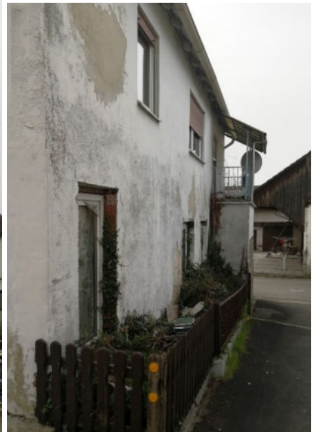
Sichtbar zugemauerte ehemalige Garagenzufahrt, dieser Teil(bereich) dient nun als Küche
