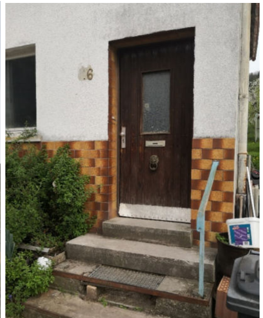
Schadhafte Hauszugangstreppe, direkt vom öffentlichen Grund gehend
