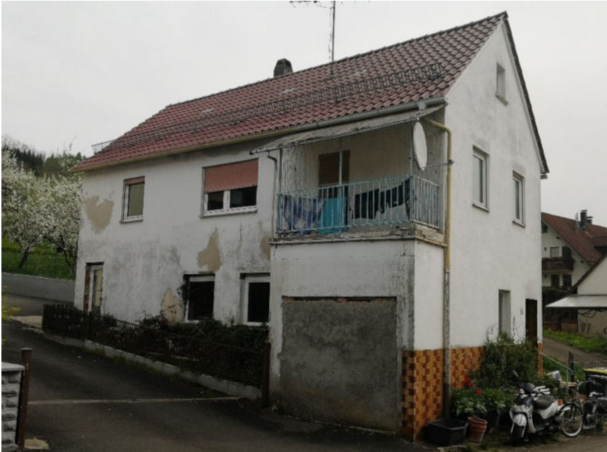
Sichtbar zugemauerte ehemalige Garagenzufahrt, dieser Teil(bereich) dient nun als Küche
