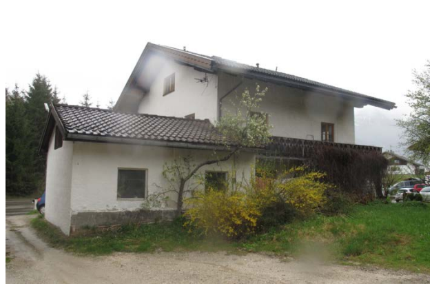
Teilfläche A - Zweifamilienhaus von Nordwesten
