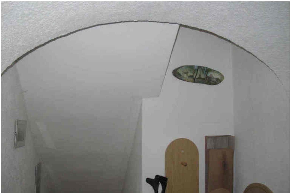
Foto 10 – Teilfläche A – ZFH – Wohnung im EG/OG – Treppe
