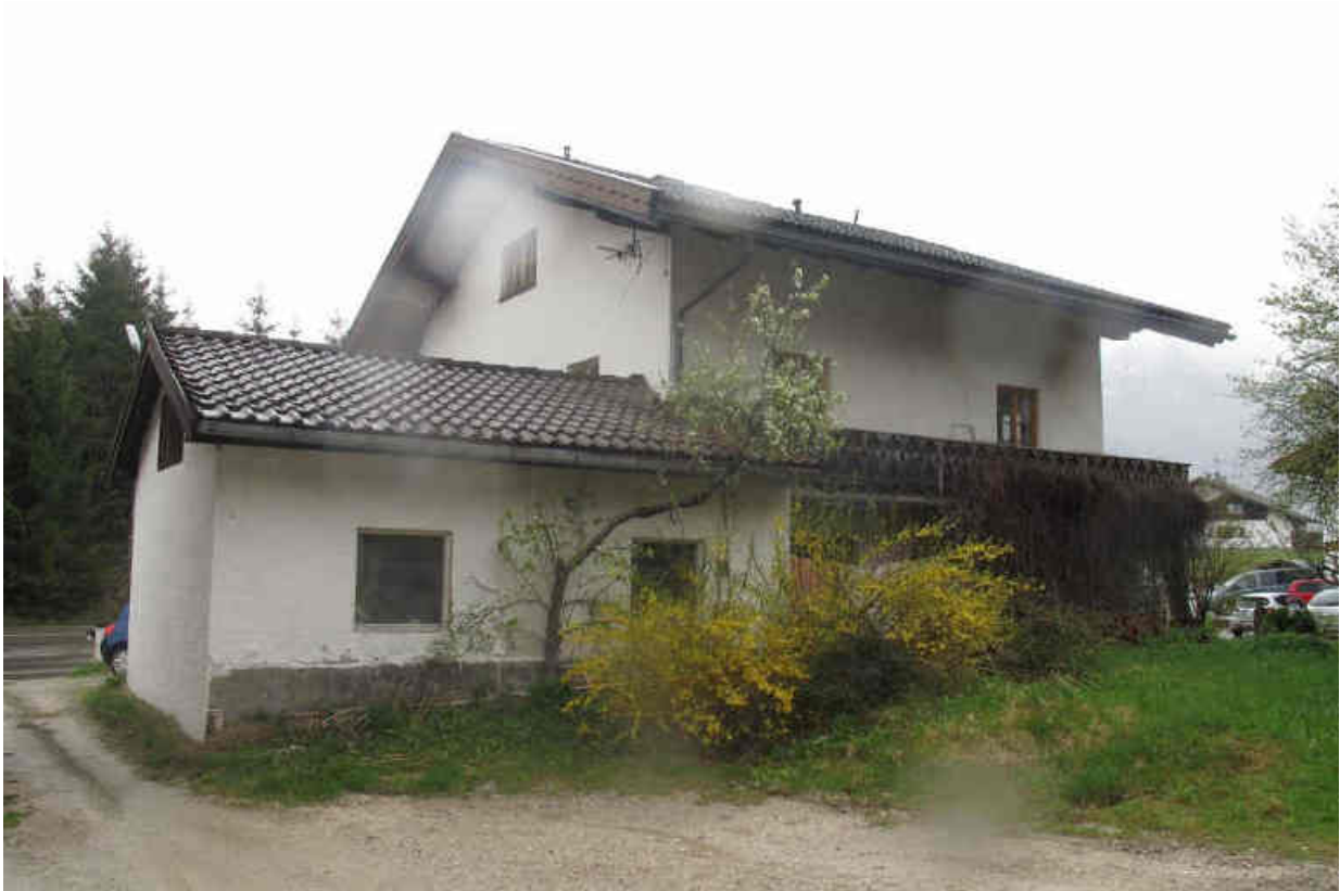
Foto 3 – Teilfläche A - ZFH von Nordwesten
