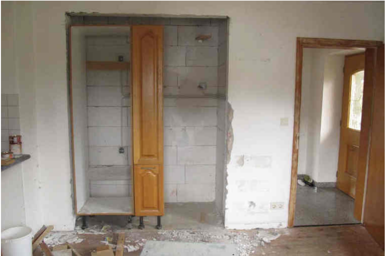
Foto 15 – Teilfläche A – ZFH – Wohnung im OG/OG – Küche im OG
