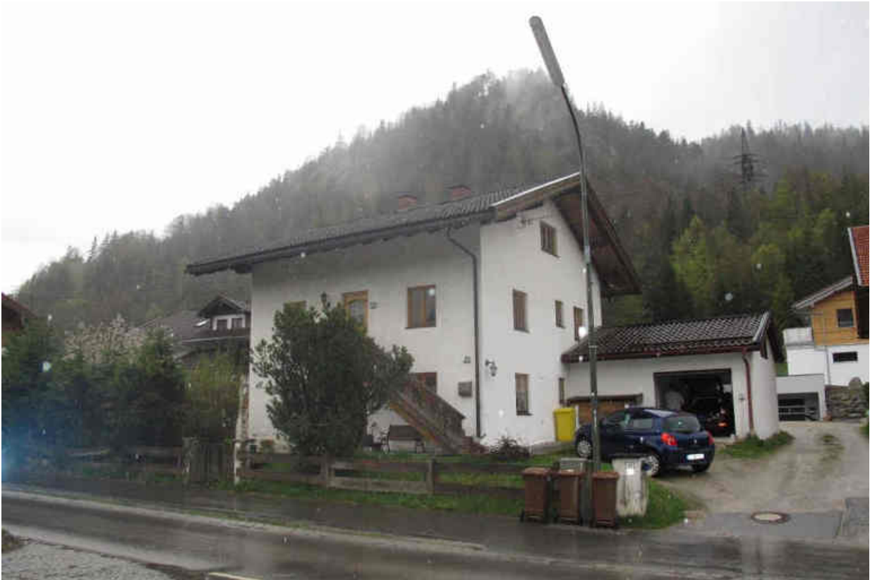
Foto 1 – Teilfläche A – Zweifamilienhaus (ZFH) von Nordosten
