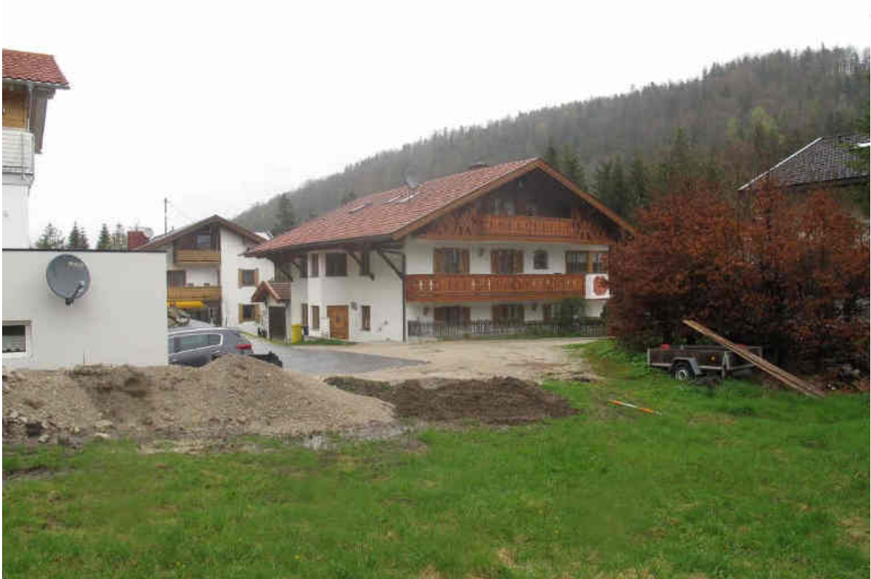
Foto 19 – Teilfläche B – Zufahrt über die Teilfläche A
