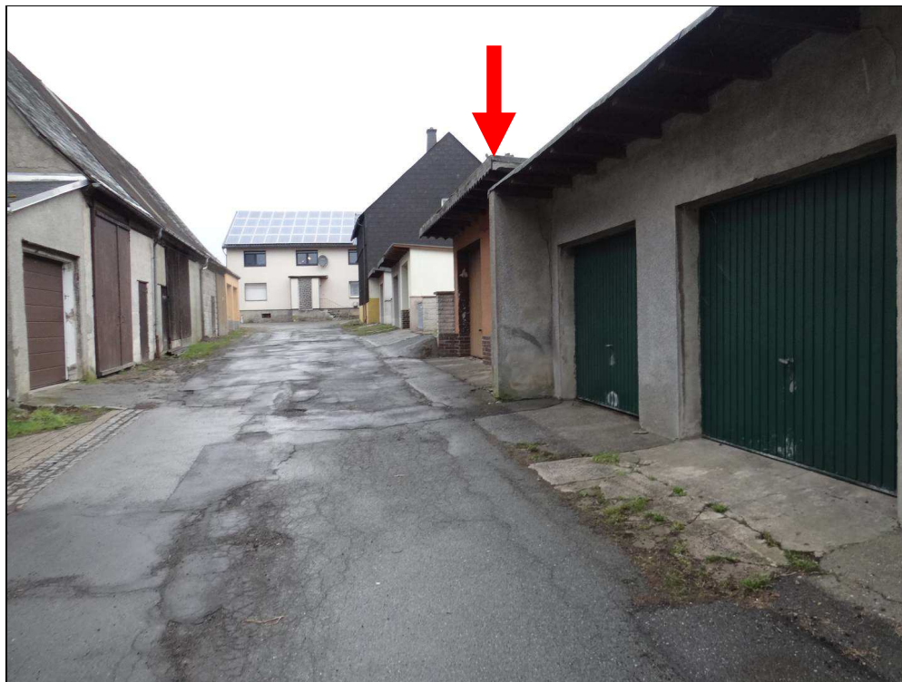
Bild 3: Süd-West-Ansicht des Garagengebäudes
