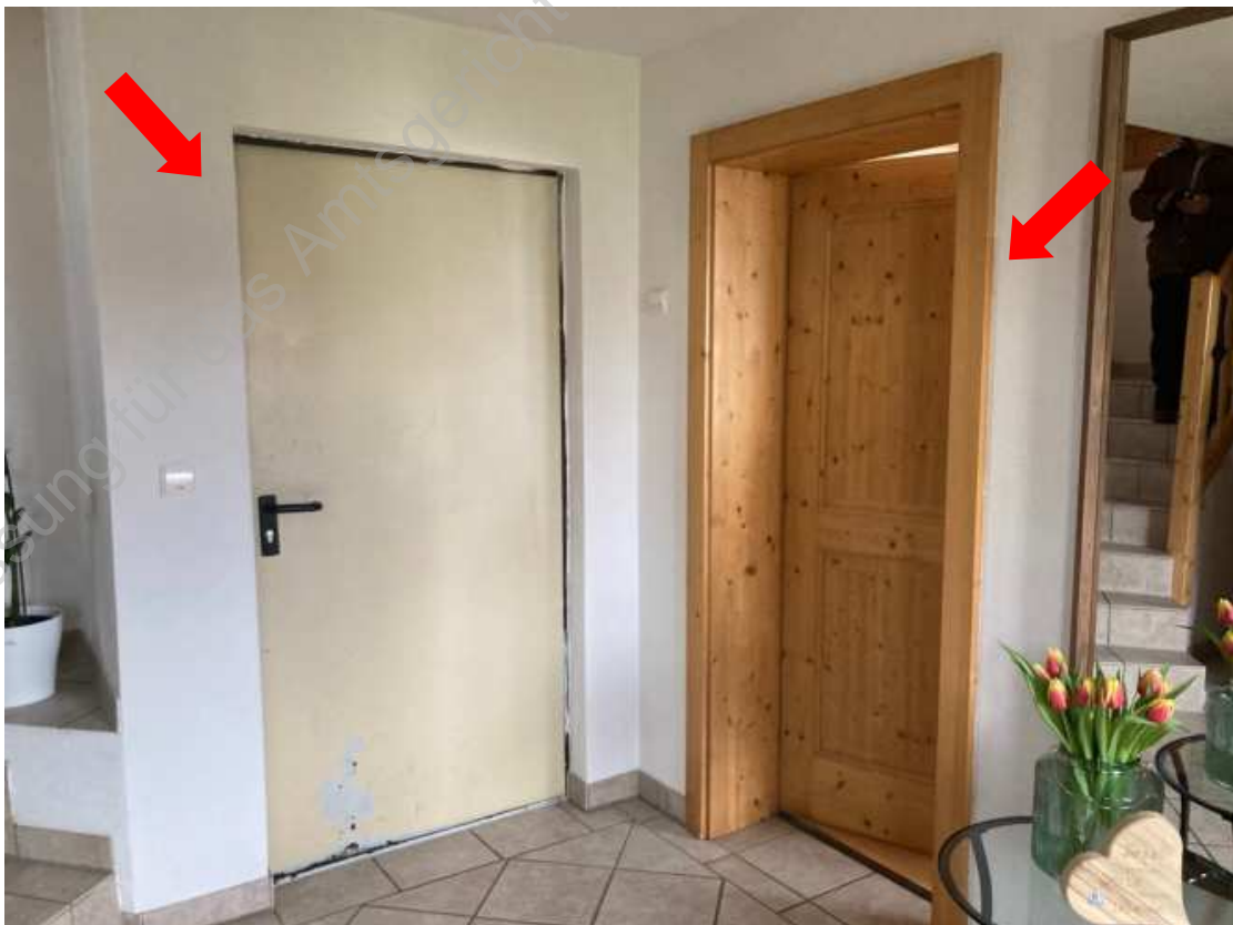
Foto 15: links Zugang Keller, rechts Zugang Apartment
