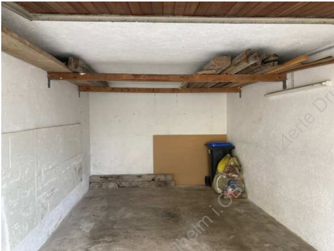
Foto 13: Innenraum Garage rechts
