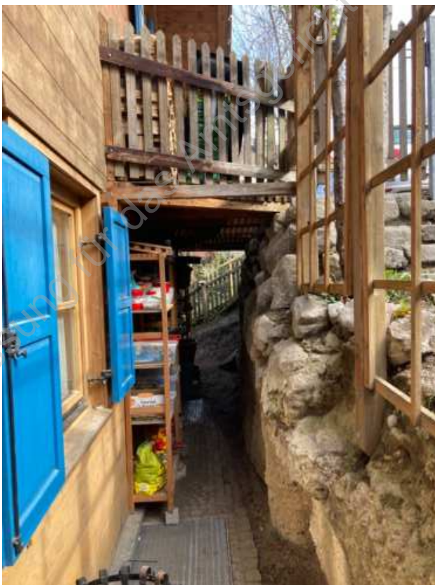
Foto 9: Bruchsteinmauer im Osten
