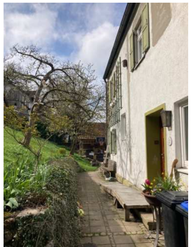
Foto 8: Hauseingang an der Ostseite
