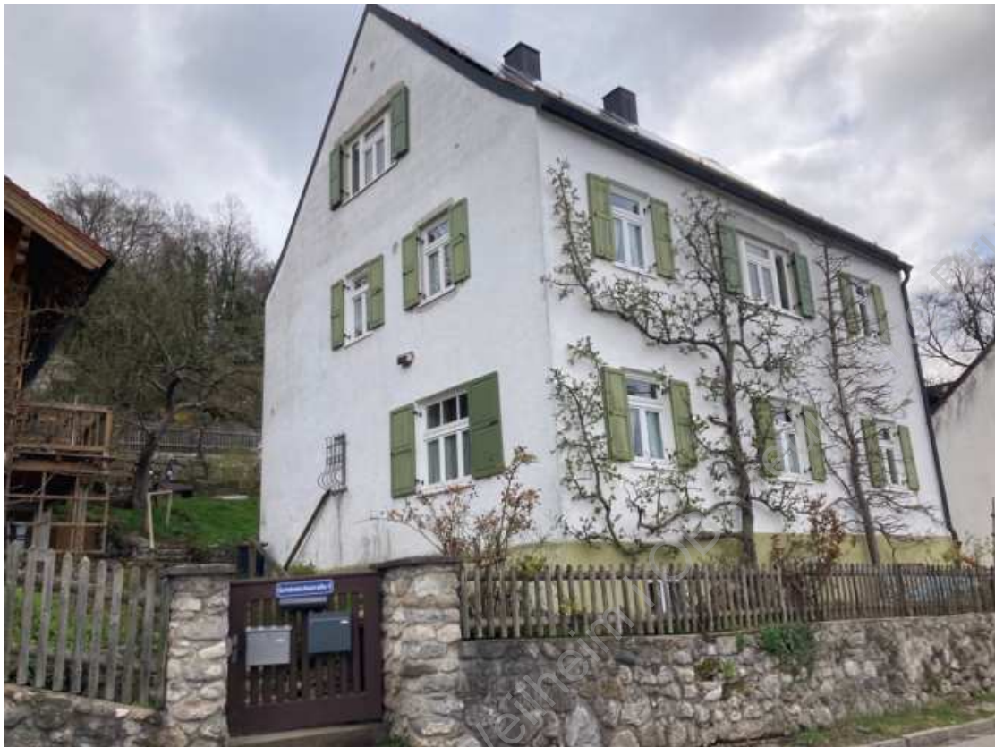
Foto 1: Blick von Nordwesten
