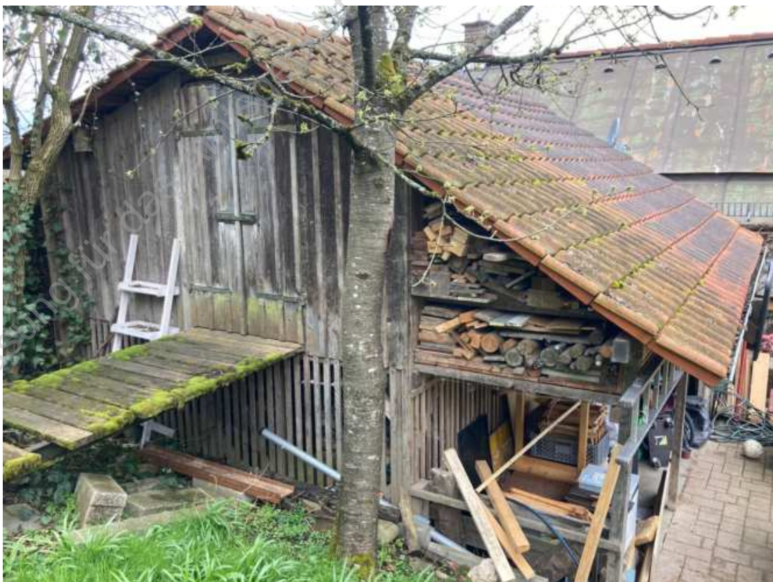
Foto 10: Holzschuppen, Zugang zum Lager im Dachgeschoss
