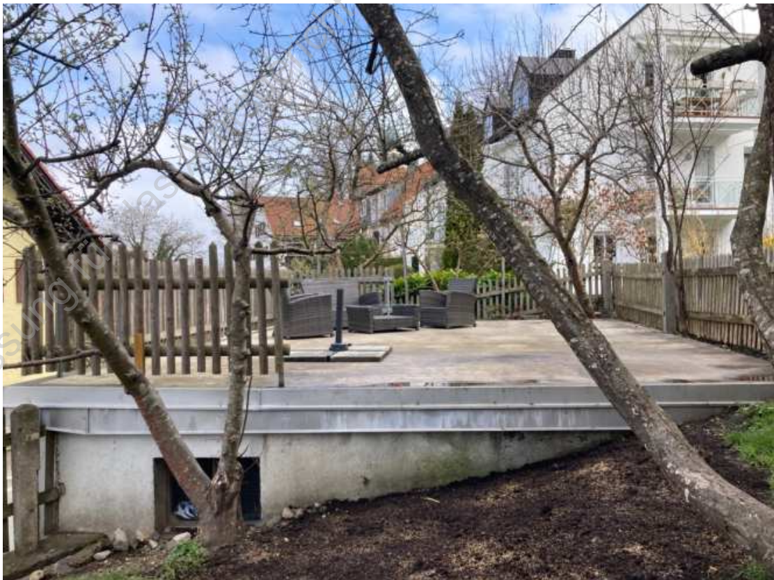
Foto 12: Garagendach, Blick von Süden
