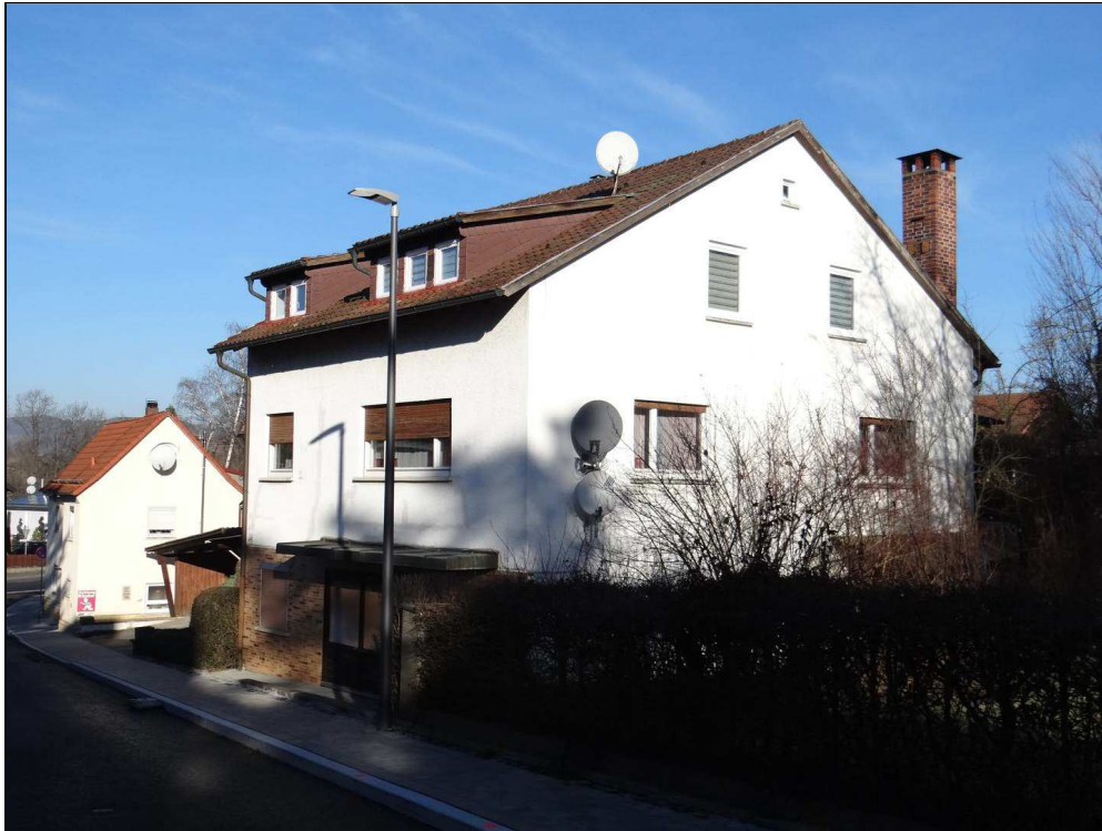
Bild 1: Blick auf das Anwesen von Süden
