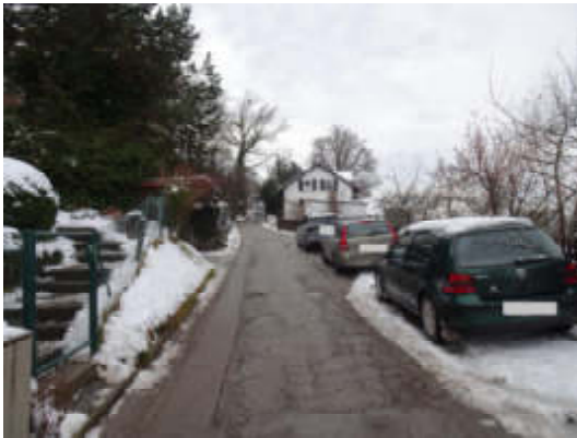
Straße „Leitenhöhe“ – Blickrichtung Süd
