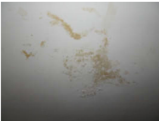
Feuchtigkeitsspuren Dachschräge
