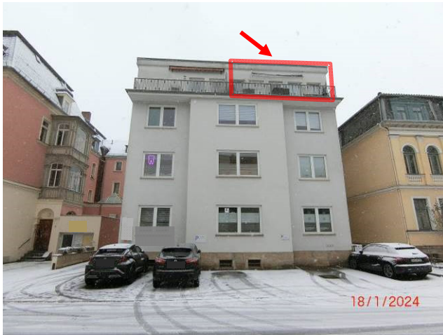
Blick von Südosten auf das Wohn- und Praxishaus mit Wohnungseigentum Nr. 7 im 3. Obergeschoss (rot markiert)
