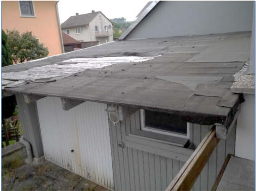
Bild 9 BBT Garage mit rückwärtiger Überdachung, Westseite
