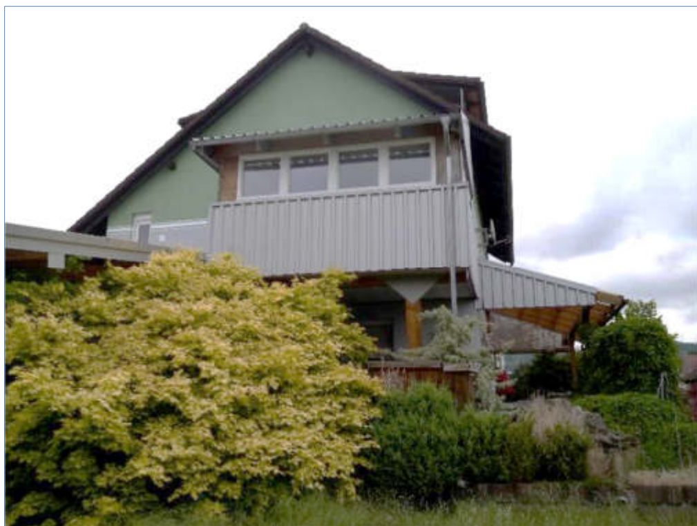
Bild 4 Pos. 01 Wohnhaus, Westseite
