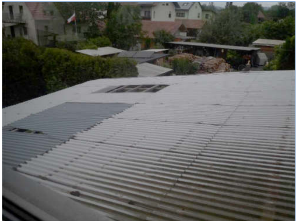
Bild 12 BBT Freisitz Westseite, Dach
