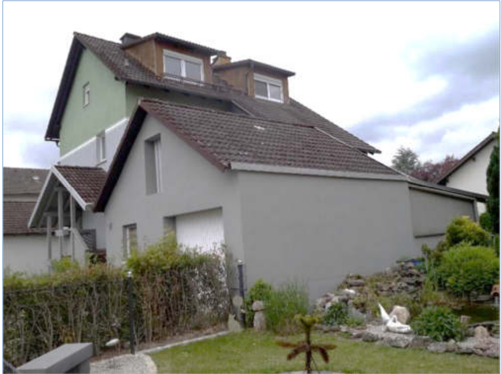
Bild 7 Pos. 01 Wohnhaus und BBT Garage, Nordseite
