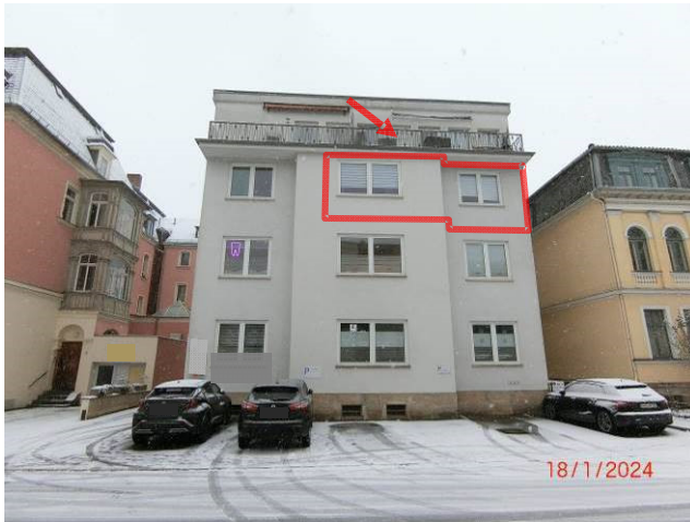
Blick von Südosten auf das Wohn- und Praxishaus mit Wohnungseigentum Nr. 5 im 2. Obergeschoss (rot markiert)
