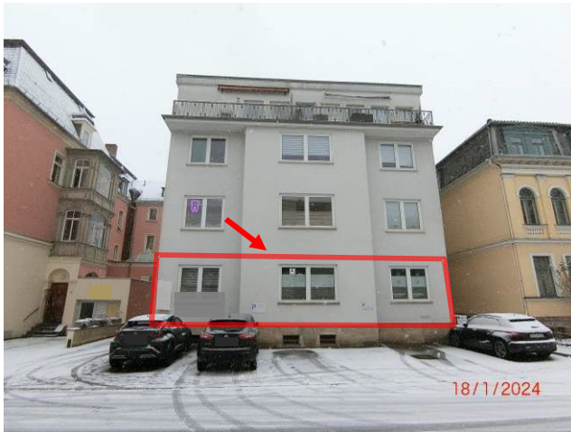
Blick von Südosten auf das Wohn- und Praxishaus mit Teileigentumseinheit Nr. 3 im Erdgeschoss (rot markiert)
