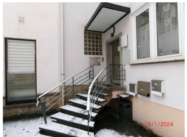
Eingang zum Wohn- und Praxishaus an der Nordwestseite
