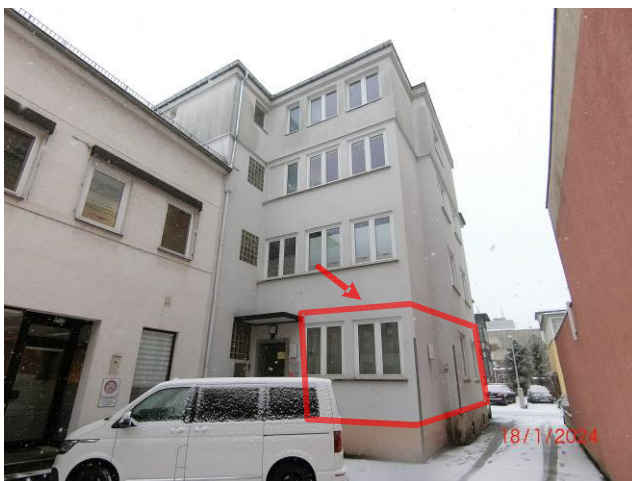
Blick von Westen auf das Wohn- und Praxishaus mit Teileigentumseinheit Nr. 3 im Erdgeschoss (rot markiert)
