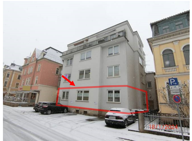
Blick von Osten auf das Wohn- und Praxishaus mit Teileigentumseinheit Nr. 3 im Erdgeschoss (rot markiert)
