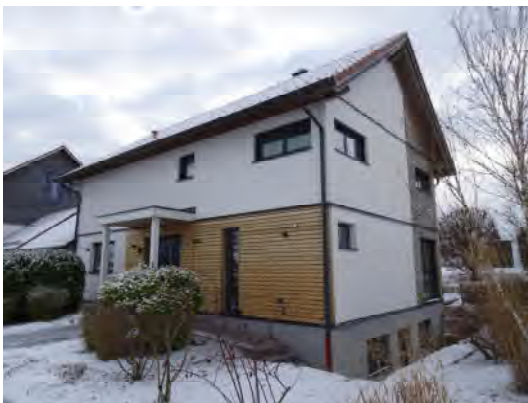
Nord- und Westseite des Gebäudes
