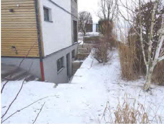
Westlicher Grundstücksbereich mit Abböschung
