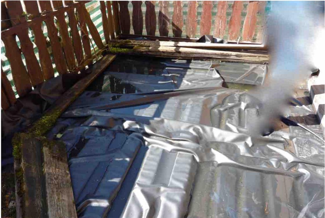
**Bild 05:** Blick auf die defekte Dachabdichtung über dem Windfang.
