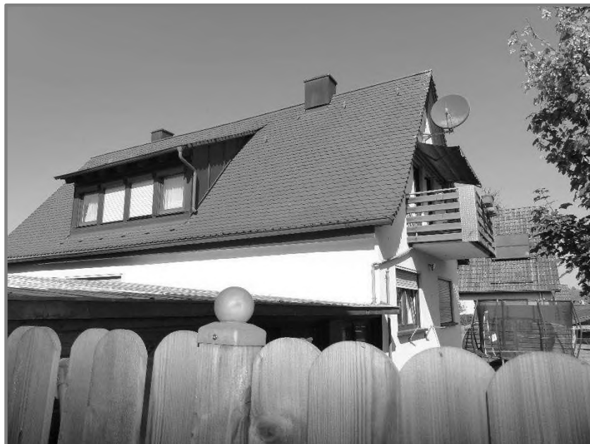
Wohnhaus mit Garage - Ansicht von Südosten
