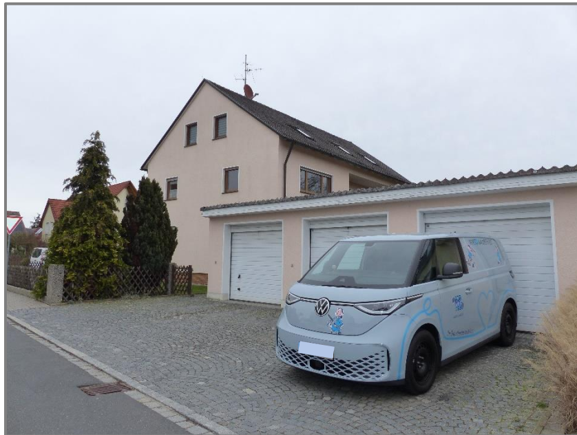
südwestlicher Grundstücksbereich mit Westansicht des Dreifamilienhauses und des Garagengebäudes
