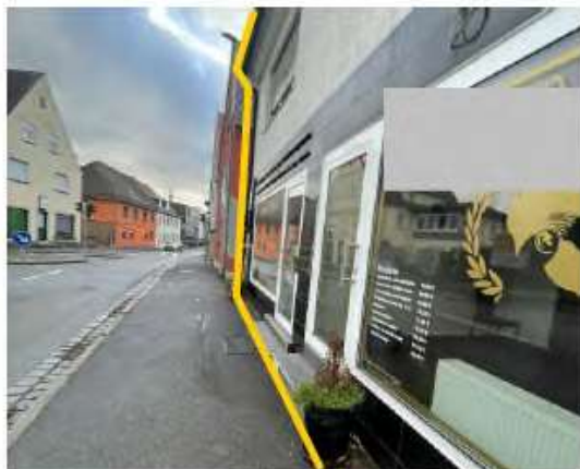
Hauptgebäude: Straßenseite Gebäudefassade O, Schaufenster im EG mit Zugängen zu jeweiligen Gewerbeeinheiten
