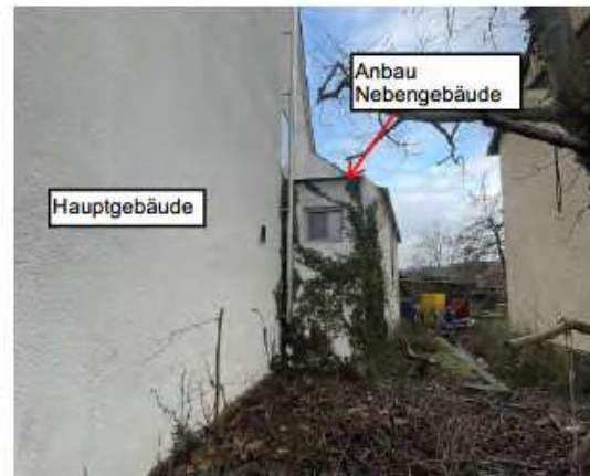
Blick von der Straße entlang der Hausfassade Richtung NW
