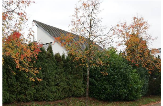
Blick von Südosten auf das Bewertungsobjekt
