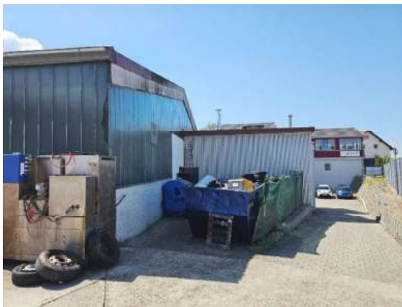
Zufahrt zur Tiefgarage, zum Sozialraumanbau und zur Hofseite des Geschäftshauses,
