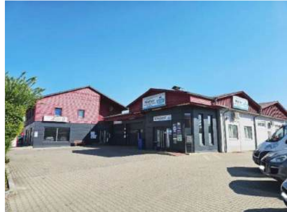
Hofbereich mit Eingang Anmeldung und Waschanlage
