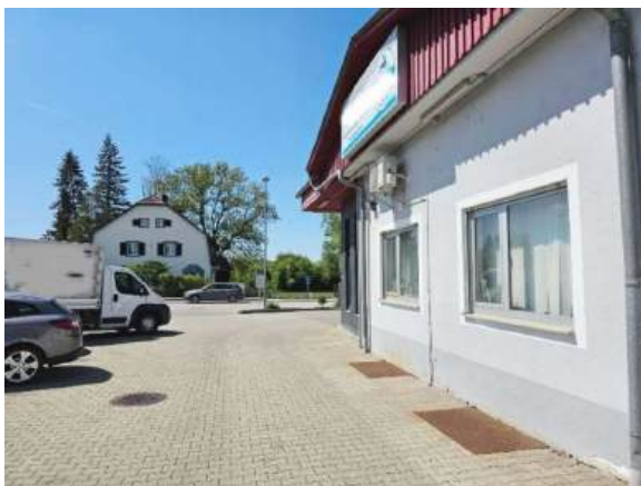
Werkstattgebäude westlicher Teil
