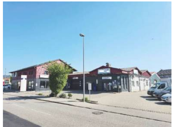
Ansicht Geschäftshaus mit Werkstatt von Süden
