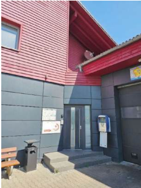
Eingang zum Treppenhaus
