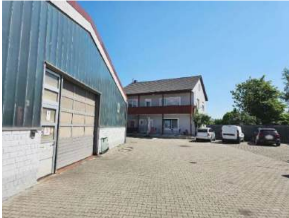
Ansicht Wohnhaus von Westen
