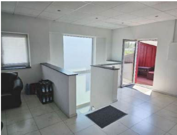
Treppenhaus OG mit Ausgang zur Dachterrasse
