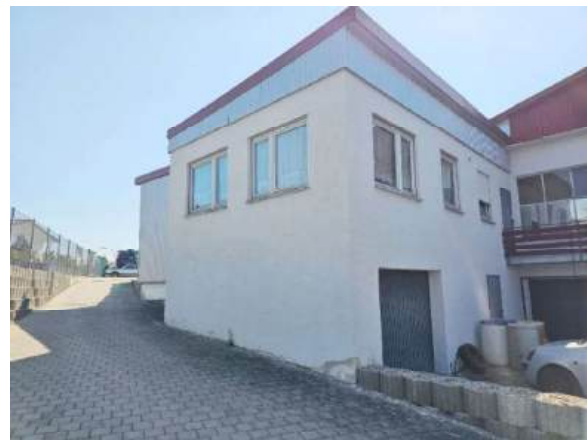
Sozialraumanbau, Ansicht von Westen
