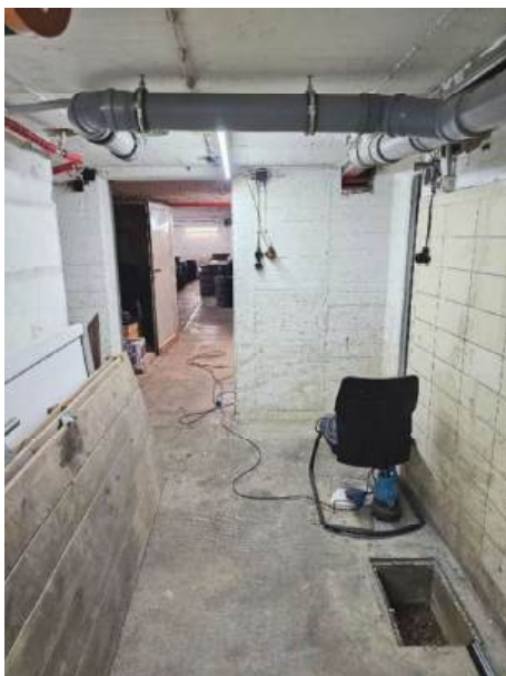
Keller/ Flur mit Treppe
