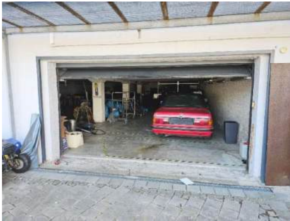
Toreinfahrt Tiefgarage unterhalb westlichem Werkstattgebäude
