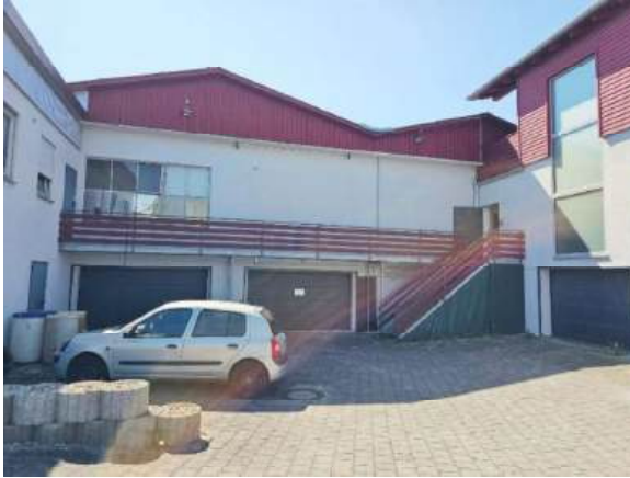
Ansicht Werkstatt mit Geschäftshaus
