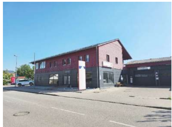
Ansicht von Südwesten
