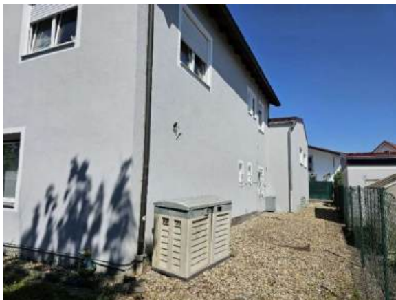
Ansicht von Südosten
