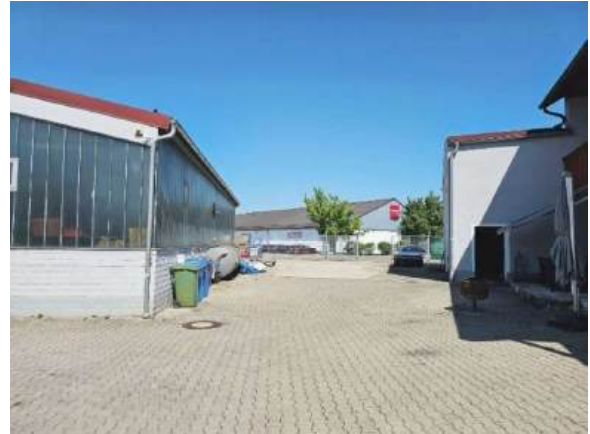
Zufahrt Goethestraße, Ansicht vom Hof aus
