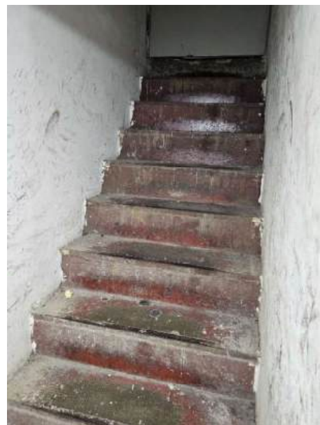
Keller/ Treppe zum Erdgeschoss westliches Werkstattgebäude
