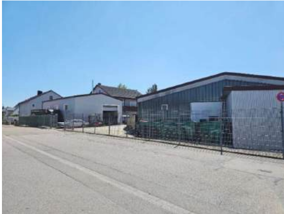
Zufahrt Goethestraße, Ansicht von Straße
