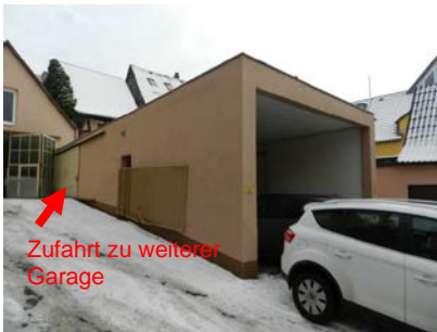
Fl.-Nr. 20; Blick auf Garagengebäude von Nordwest Zufahrt zu weiterer Garage
