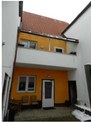
Fl.-Nr. 29; Blick vom Innenhof auf Südfassade Hs.-Nr. 12
