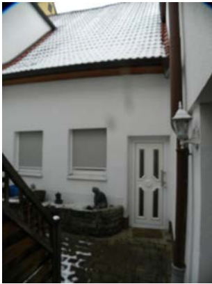
Fl.-Nr. 29; Hauseingang zur Hs.-Nr. 5, Wohnung EG vom Innenhof
