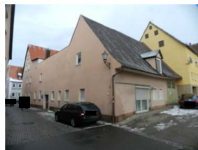
Fl.-Nr. 29; Südfassade und Westfassade Hs.-Nr. 5
