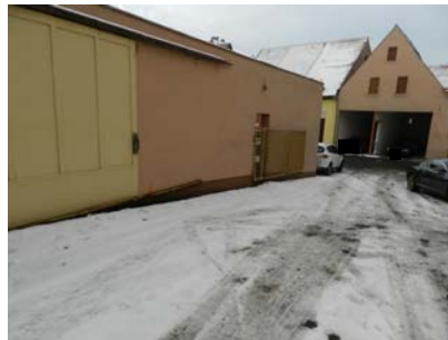
Fl.-Nr. 20; Blick entlang der Nordfassade
