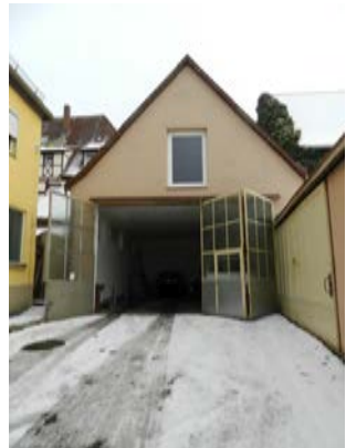
Fl.-Nr. 24; Blick auf Fl.-Nr. 24 von Westen
