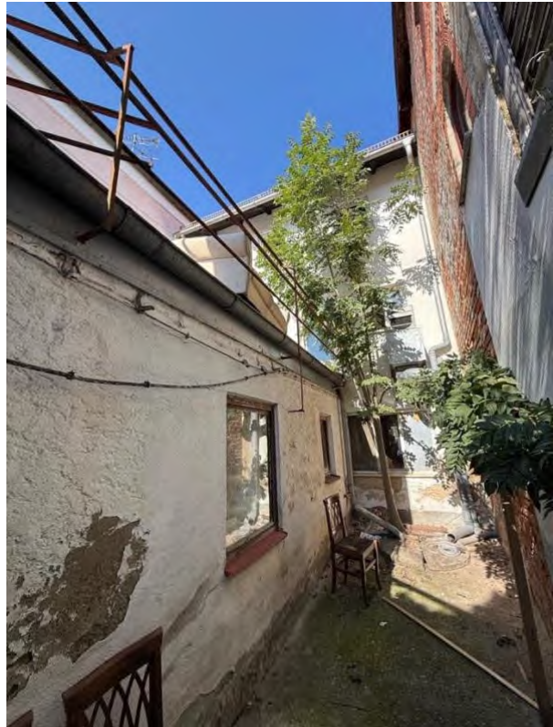
Nordfassade erdgeschossiger Anbau
