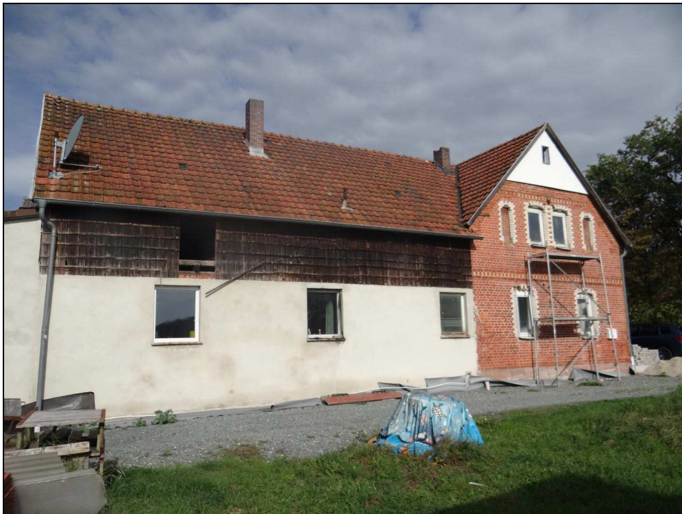
Bild 2: Süd-Ansicht Nebengebäude und Wohngebäude
