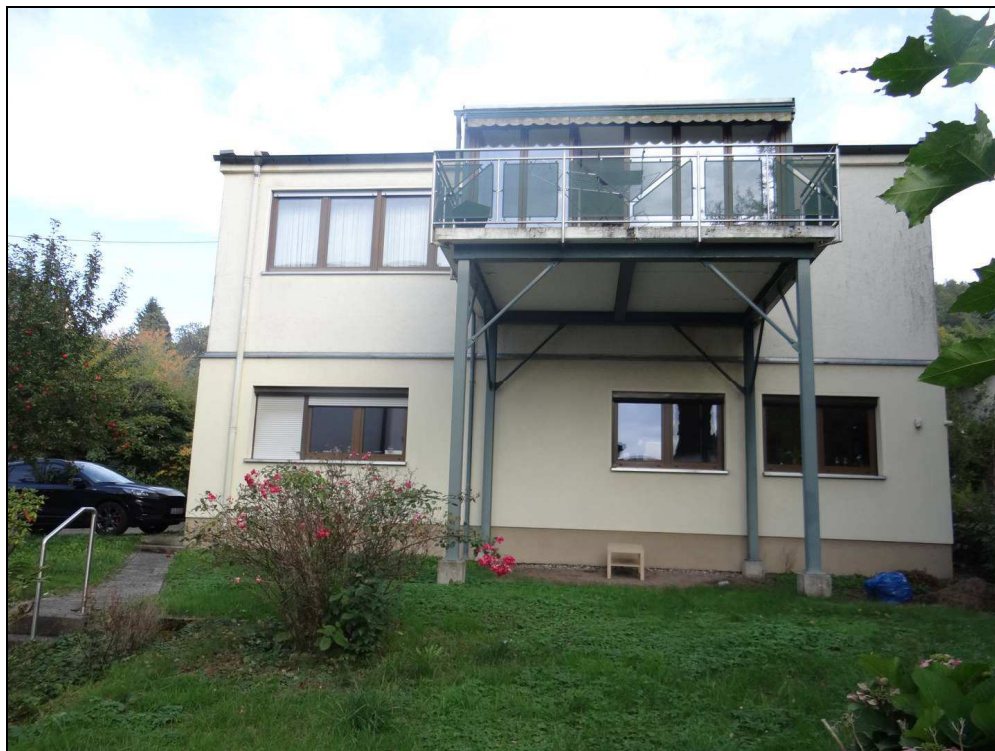
Bild 2: Süd-West-Ansicht des Wohngebäudes
