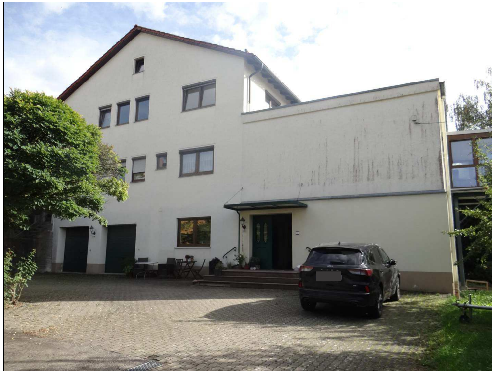
Bild 1: Blick auf das Wohngebäude von Westen
