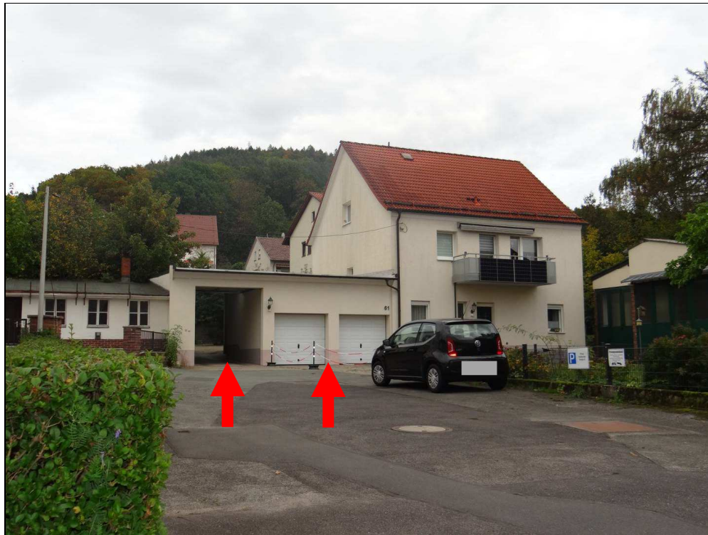
Bild 3: Süd-West-Ansicht der Zufahrt Fl.Nr. 2471/5 und der Garage Fl.Nr. 2471/10
