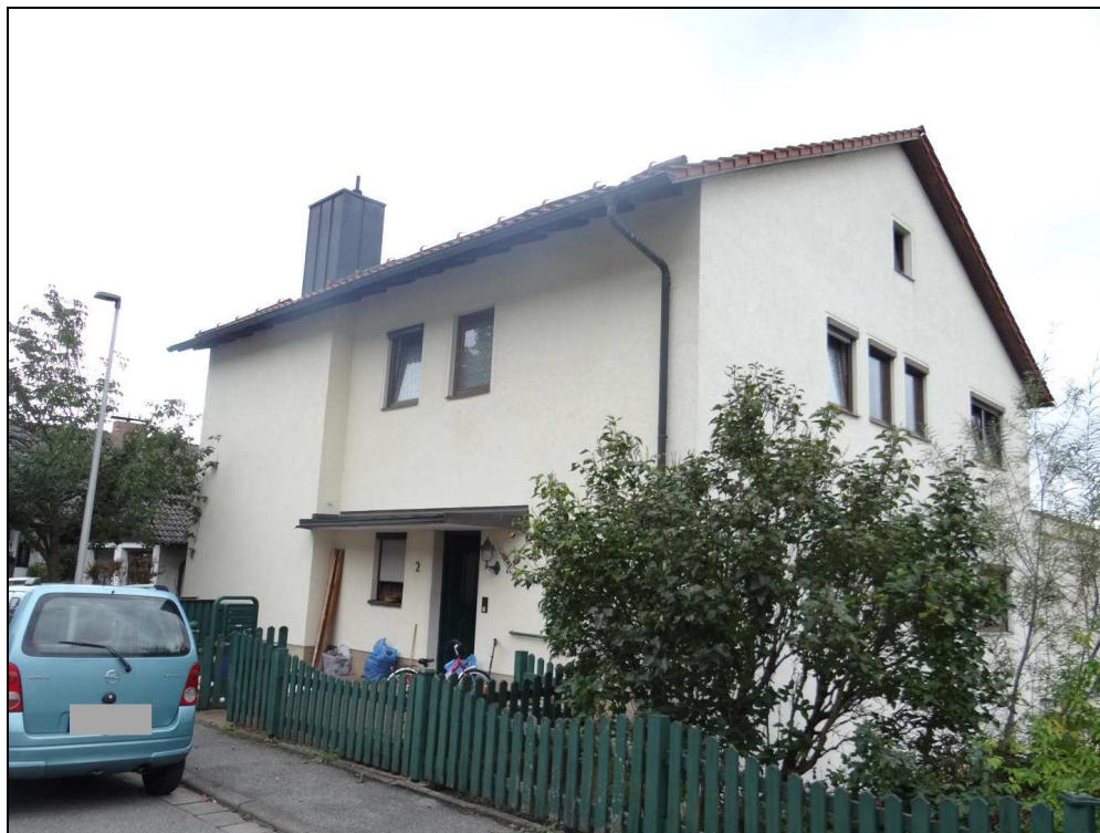
Bild 4: Nord-Ansicht des Wohngebäudes Fl.Nr. 2471/5
