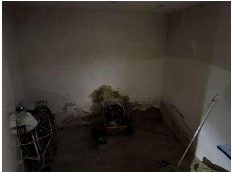
Feuchteschäden Keller
