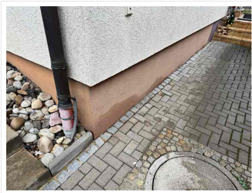
Nr. 7 Zustand Zuwegung
