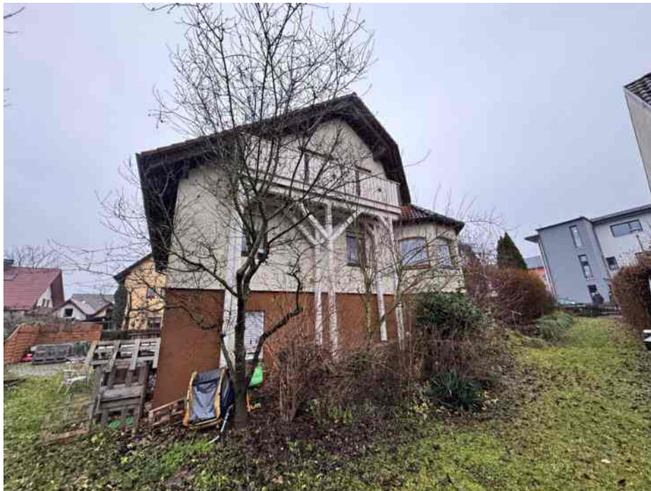
Nr. 9 Zustand Garten
