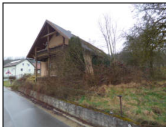
Ansicht von Südosten
