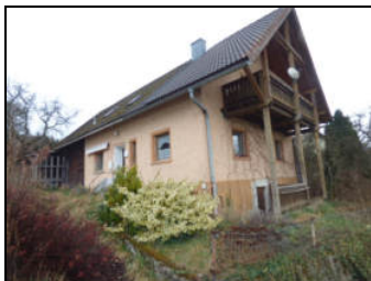
Ansicht von Süden (Gebäudezugang)
