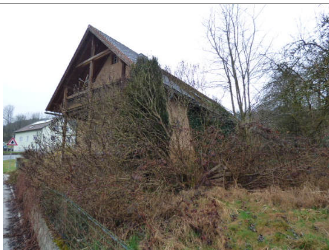
Gesamtansicht von Südosten
