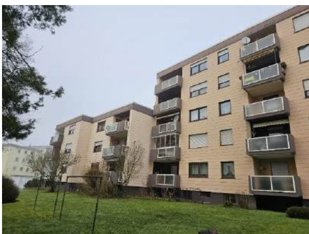
Haus Nr. 4, 6 / Ansicht von Südosten
