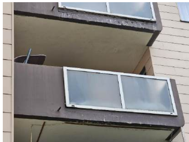
Abplatzungen Balkonunterseiten
