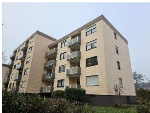
Haus Nr. 6, 8 / Ansicht von Südosten
