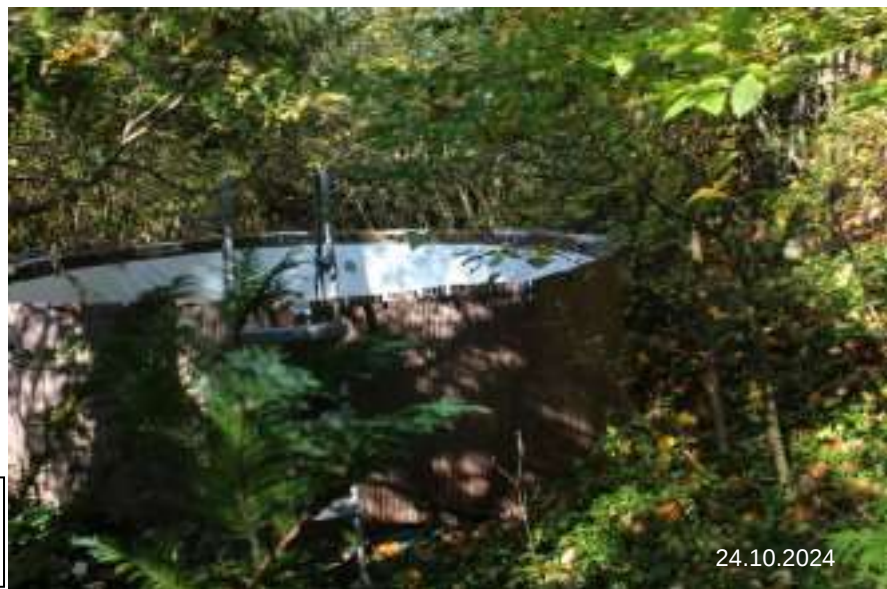
Bild 11: Fl.Nr. 908/7 Ansicht Poolbecken von Süden
