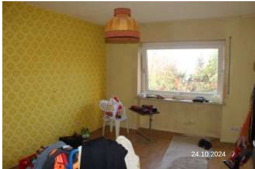
Bild 28: Fl.Nr. 908 Anbau Süden W4: KG – Schlafen
