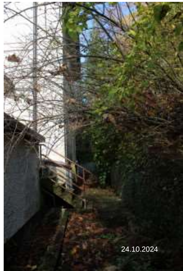
Bild 13: Fl.Nr. 908+908/7 Wohnhaus Ansicht Südostecke Wohnhaus + Anbau Süden mit Umgang entlang Ostseiten von Süden
