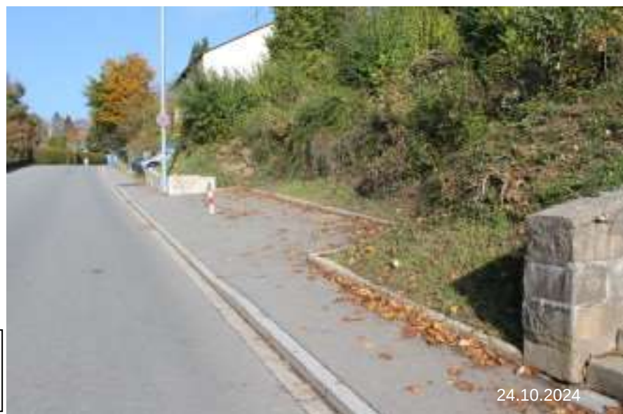
Bild 2: Fl.Nr. 908/6 Ansicht Strassenseite - Parkbucht- von Süden
