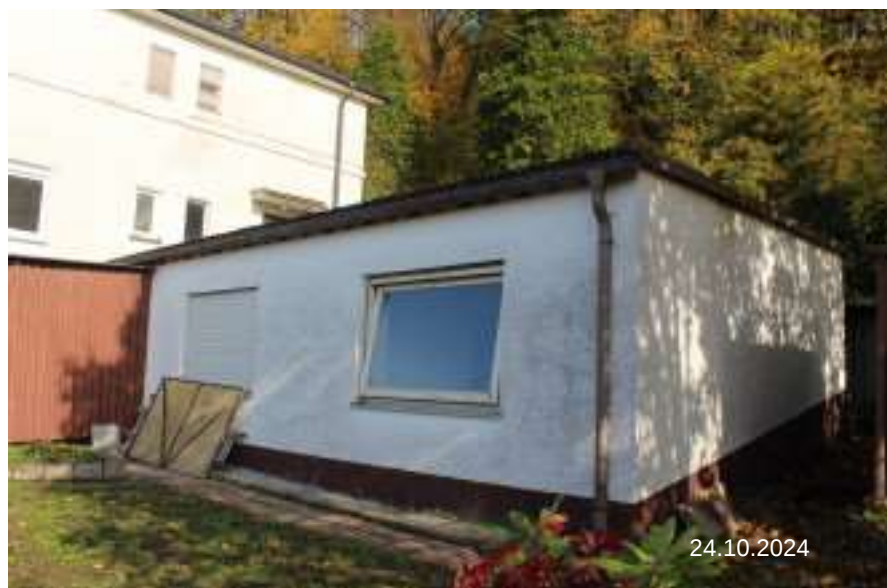
Bild 6: Fl.Nr. 908+908/6 Anbau Süden Ansicht Anbau von Süden
