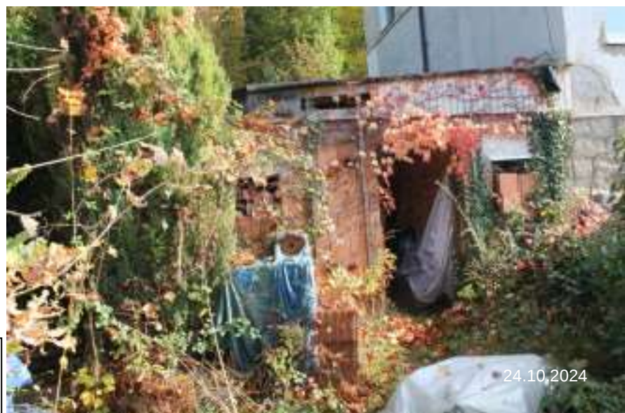
Bild 9: Fl.Nr. 908/7 Ansicht Anbau Norden von Nordwesten
