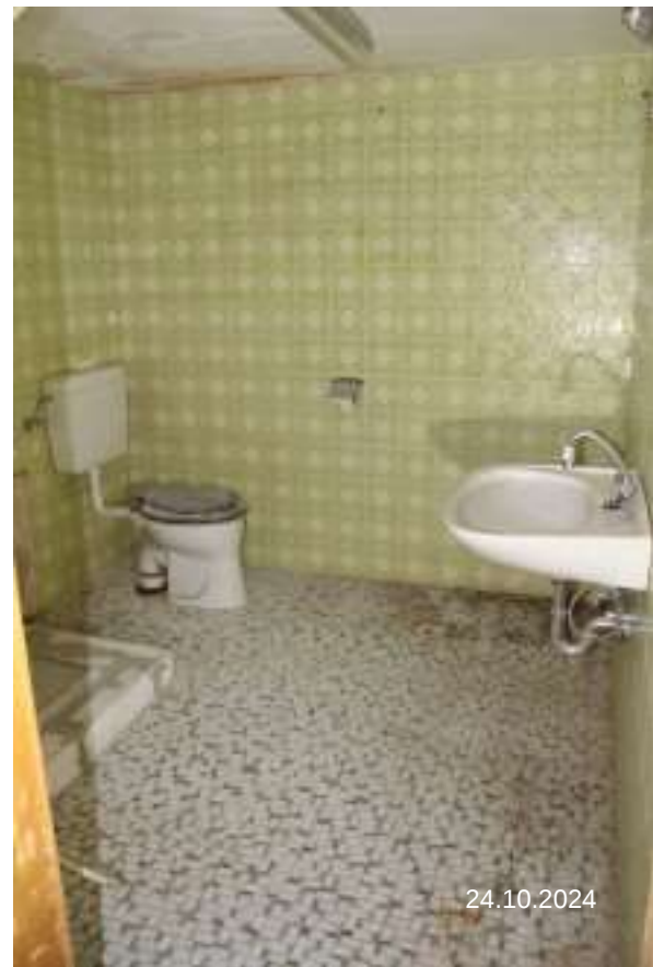
Bild 26: Fl.Nr. 908/6 Anbau Süden W4: KG – Bad
