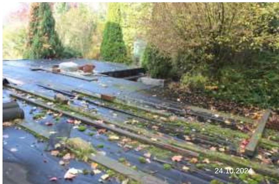
Bild 12: Fl.Nr. 908/7 Ansicht provisorisches Dach auf Anbau Norden von Süden
