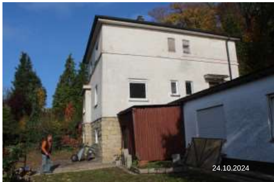
Bild 5: Fl.Nr. 908+908/6 Wohnhaus Ansicht Wohnhaus + Anbau Süden von Süden
