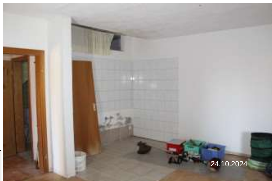
Bild 27: Fl.Nr. 908/6 Anbau Süden W4: KG – Wohnküche
