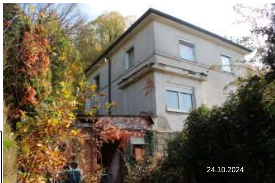
Bild 8: Fl.Nr. 908+908/7 Wohnhaus Ansicht Wohnhaus und Anbau Norden von Nordwesten
