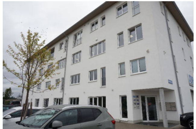
Blick von Südwesten auf Westfassade und Eingangsbereich
