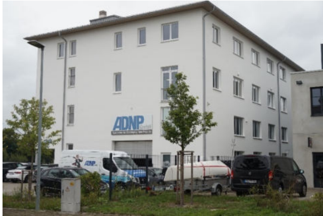
Wildmoos 3b: Blick von der Straße auf die Ost- und die Südfassade mit Rolltor zur Halle
