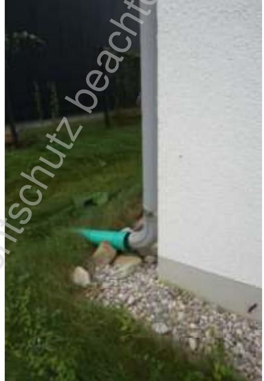
Blick bei Nordostecke: fehlender Anschluss des Fallrohrs der Dachentwässerung an die Versickerungsmulde
