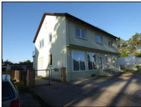
Ansicht von Nordosten (Vordergebäude)
