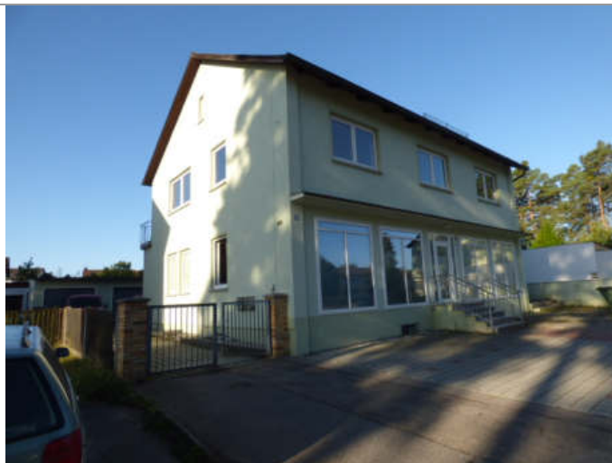
Gesamtaußenansicht von Nordosten (Vordergebäude)
