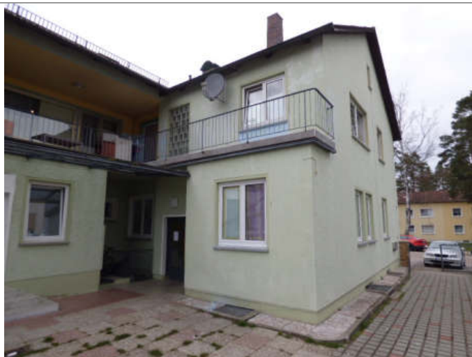
Gesamtaußenansicht von Südosten (rechts Vordergebäude, links Rückgebäude)
