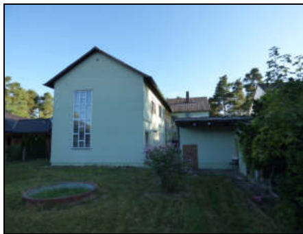
Ansicht von Süden (Rückgebäude)
