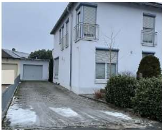
Blick von der Straße aus Richtung Garage
