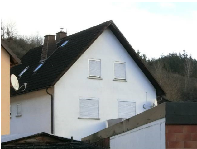
Blick von Südwesten auf das Bewertungsobjekt a) Flst. 617/4 Wohnhaus
