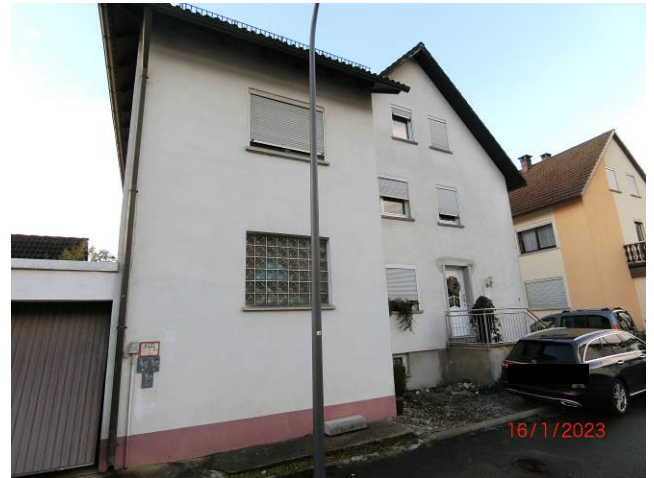
Blick von Nordosten auf das Bewertungsobjekt a) Flst. 617/4 Anbau und Wohnhaus
