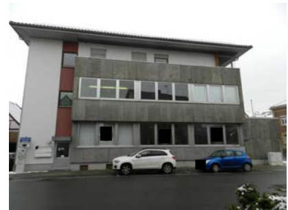
Nordfassade, Ansicht von der Parkstraße
