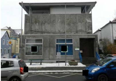
Ansicht von Westen, von der Ansbacher Straße
