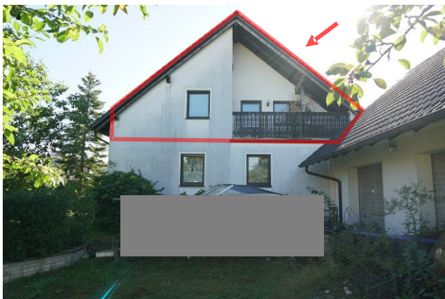
Blick von Nordwesten auf das Zweifamilienhaus mit Wohnungseigentum Nr. 2 im Dachgeschoss (rot markiert)
