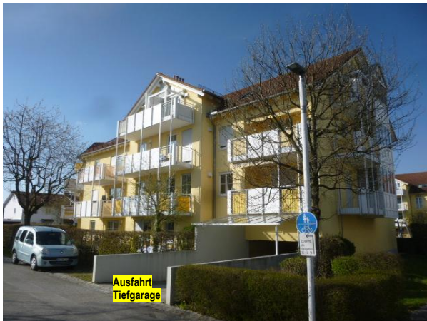
Ansicht südliches Wohnhaus
