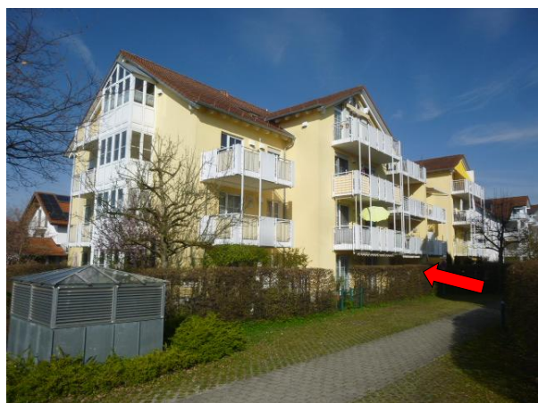
Ansicht nördliches Wohnhaus (roter Pfeil = Lage der Wohnung 01)
