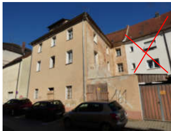
Ansicht von Südosten (Brauhausgasse)
