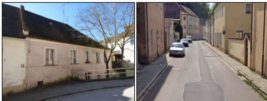
Ansichten der Erschließungsstraße Kugelplatz und Brauhausgasse mit Zustand der Erschließungsstraßen
