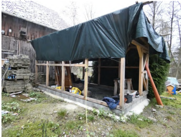
Schuppen im Rohbau
