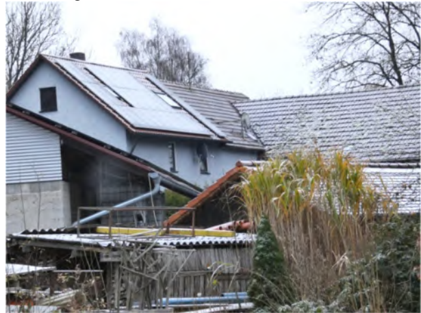
PV-Anlage auf dem Wohnhaus
