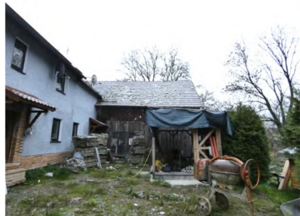
Wohnhaus mit Scheune im Hintergrund
