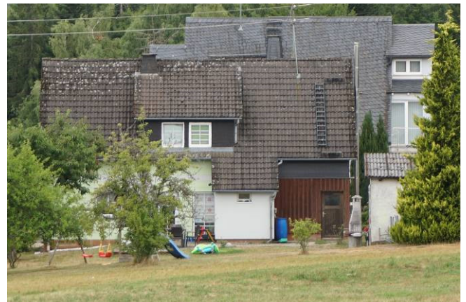
Blick von Südosten auf das Bewertungsobjekt a) Flst. 174/3
