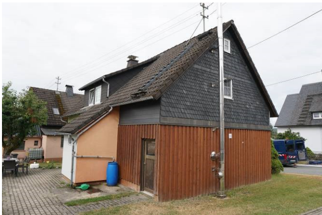
Blick von Nordosten auf das Bewertungsobjekt a) Flst. 174/3
