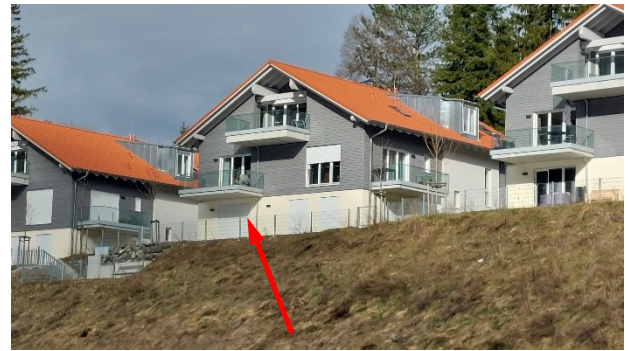
Mehrfamilienhaus von Süden
