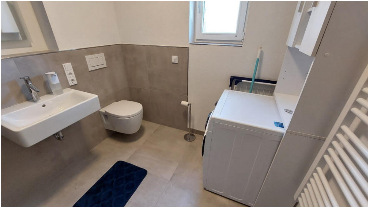
Foto 9 – Wohnung Nr. 8 – Duschbad
