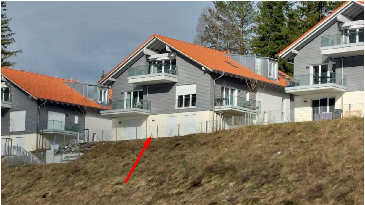
Foto 1 – Mehrfamilienhaus von Süden
