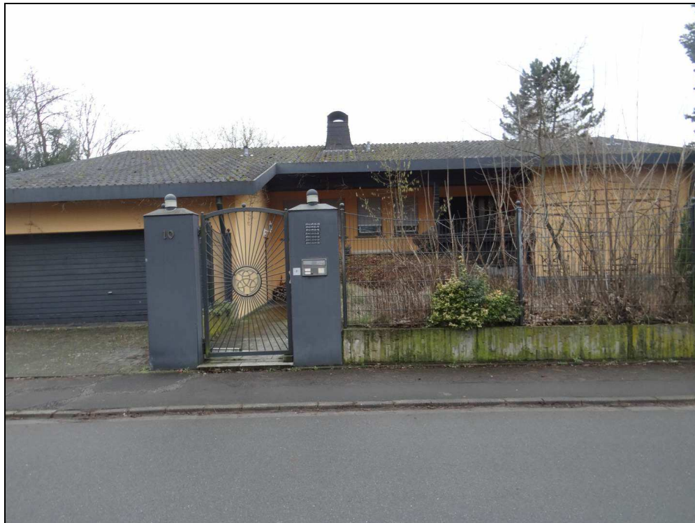
Bild 2: Nord-Ost-Ansicht des Wohngebäudes
