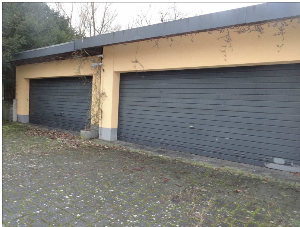
Bild 4: Nord-Ansicht der Garagen
