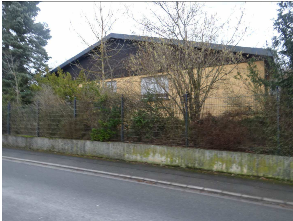
Bild 3: West-Ansicht des Grundstücks Rosenstraße 10
