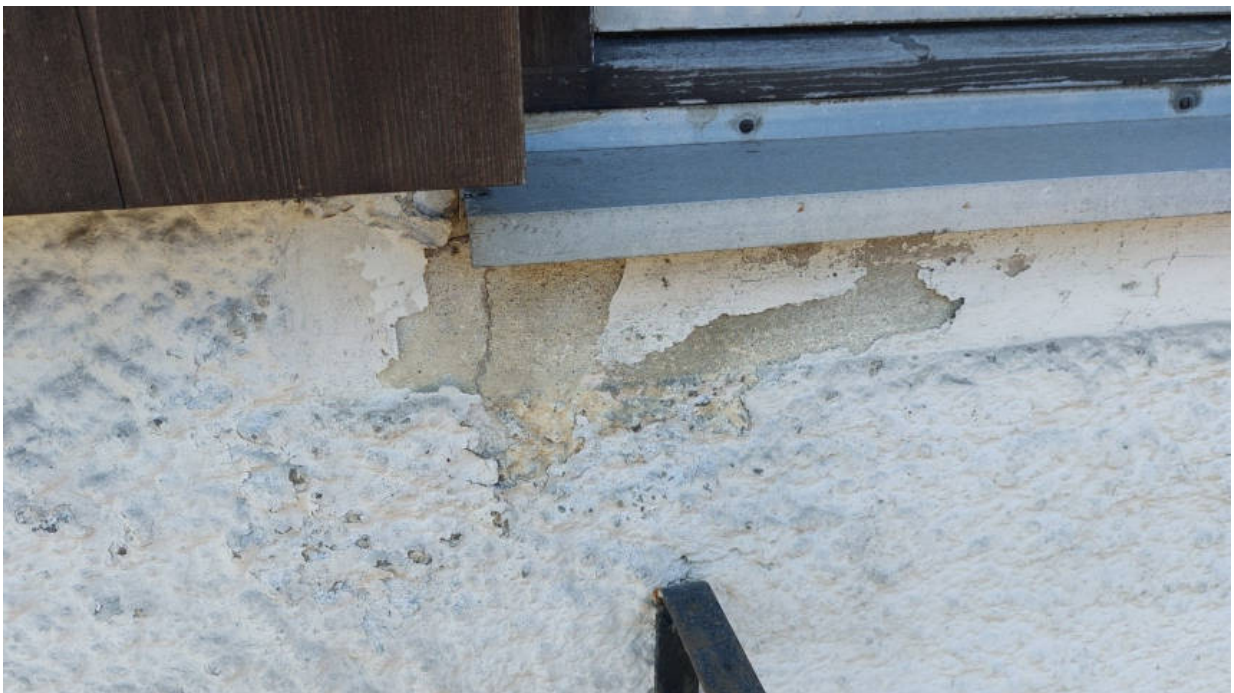
Foto 20 – Farbabplatzungen im Bereich der Fassade / Fenster mit Verwitterungsspuren
