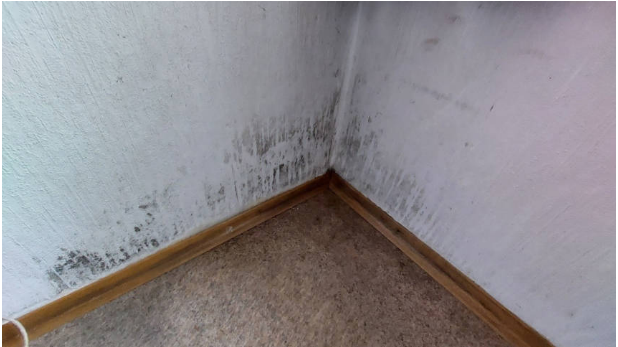
Foto 19 – Schimmelbildung im Sockelbereich an der Außenecke im Wohnzimmer im EG
