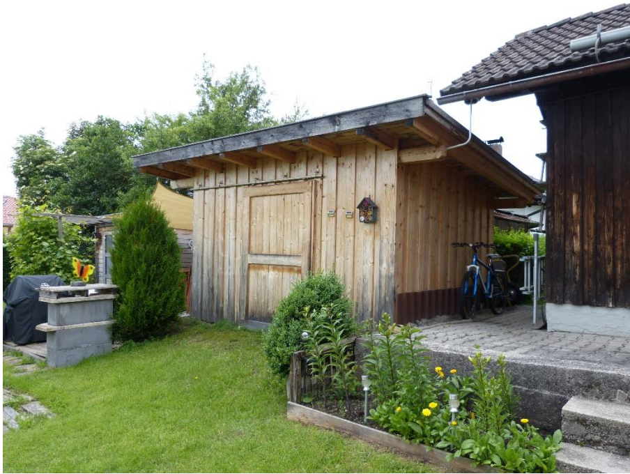
Gebäude 1: Geräteschuppen, Ansicht von Südosten
