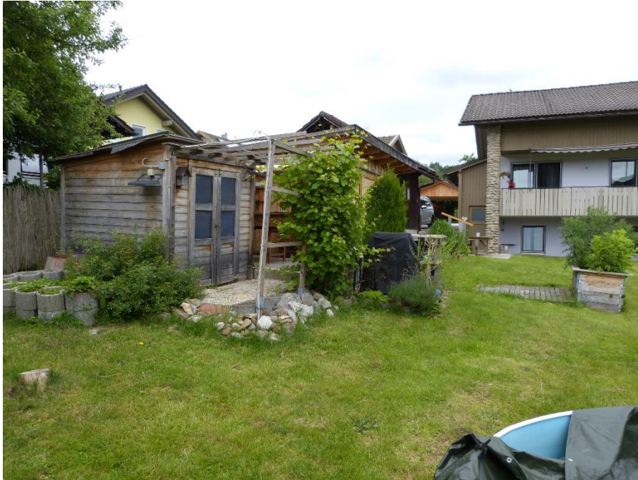
Gebäude 2: Holzschuppen, Ansicht von Süden
