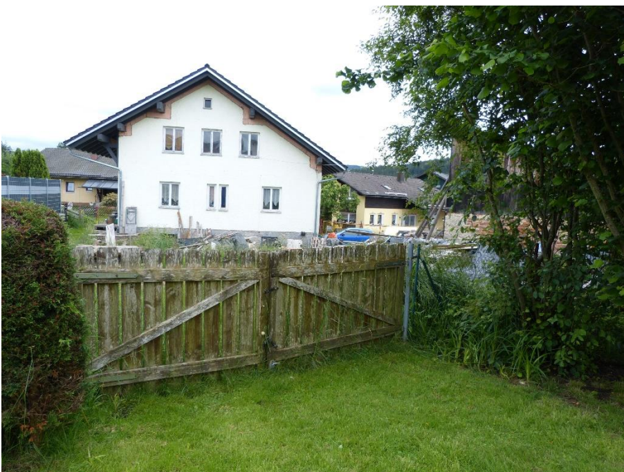
Geringfügig bebautes Grundstück, Zufahrt von Süden über Nachbargrundstück
