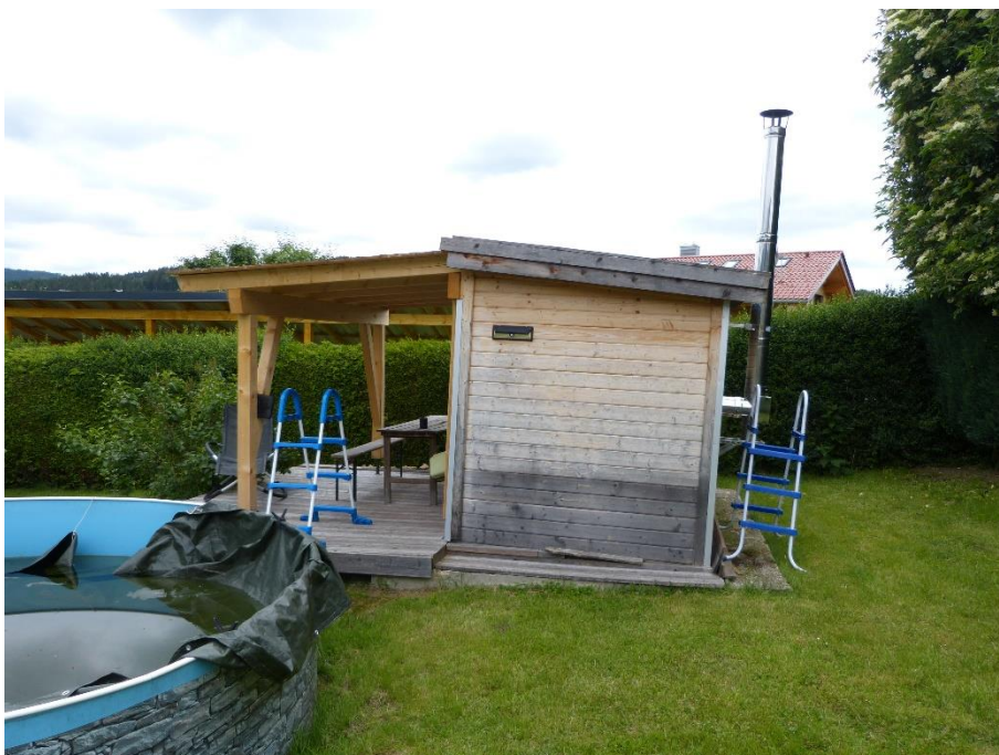
Gebäude 3: Saunagebäude, Ansicht von Nordosten
