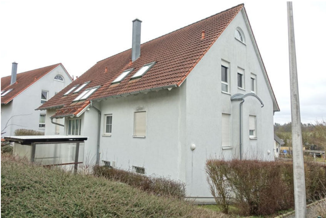
Ansicht von Westen, die Wohnung Nr. 5 ist im Dachgeschoss und Spitzboden
