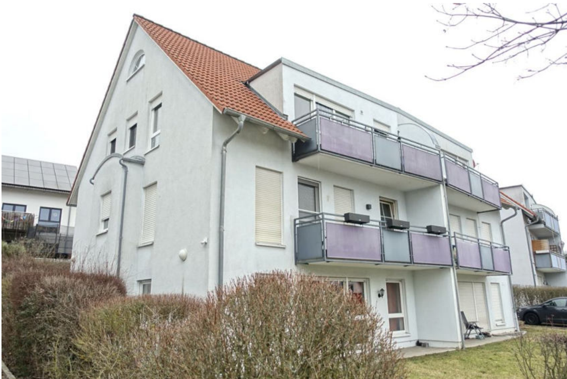
Ansicht von Süden, die Wohnung Nr. 5 ist im Dachgeschoss und Spitzboden
