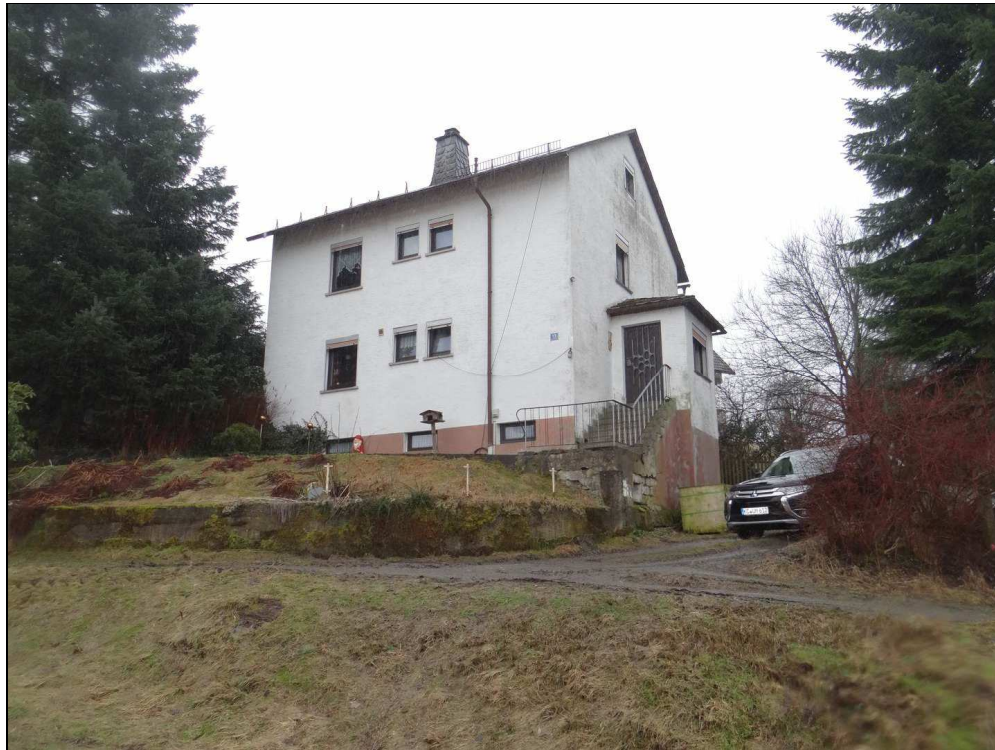
Bild 1: Blick auf das Anwesen von Norden
