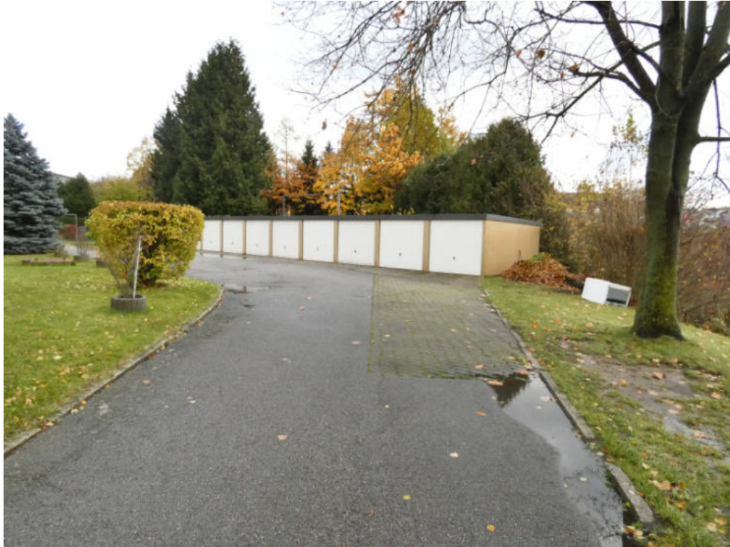
Bild 10: Garagen an der Rückseite des Grundstücks
