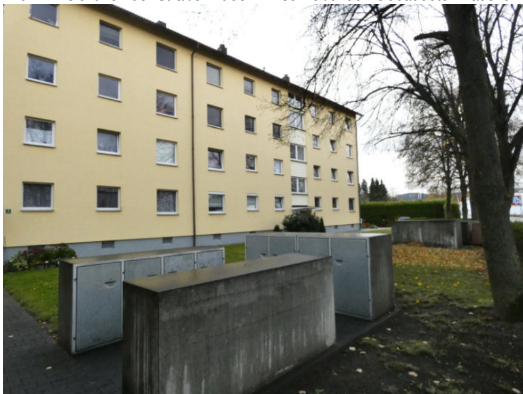
Bild 2: Ansicht von der Straße mit dem Anschließenden Gebäudeteil Hausnummer 11
