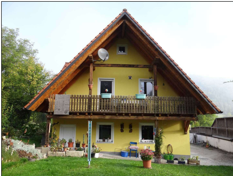
Bild 4: Süd-Ansicht Wohngebäude I
