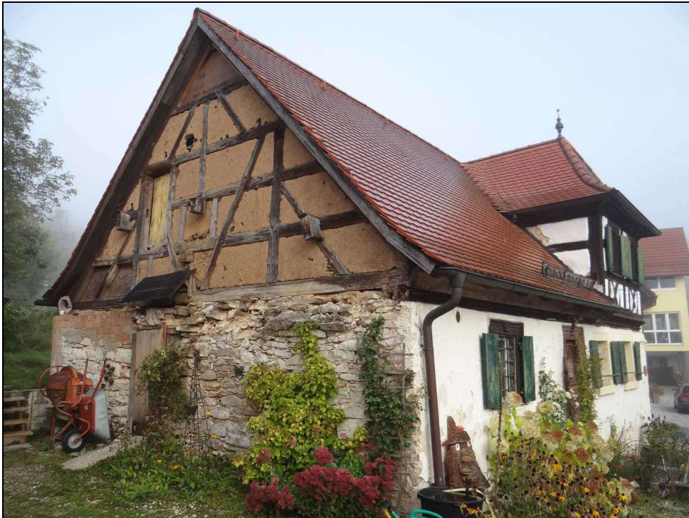
Bild 2: Süd-Ost-Ansicht Wohngebäude II
