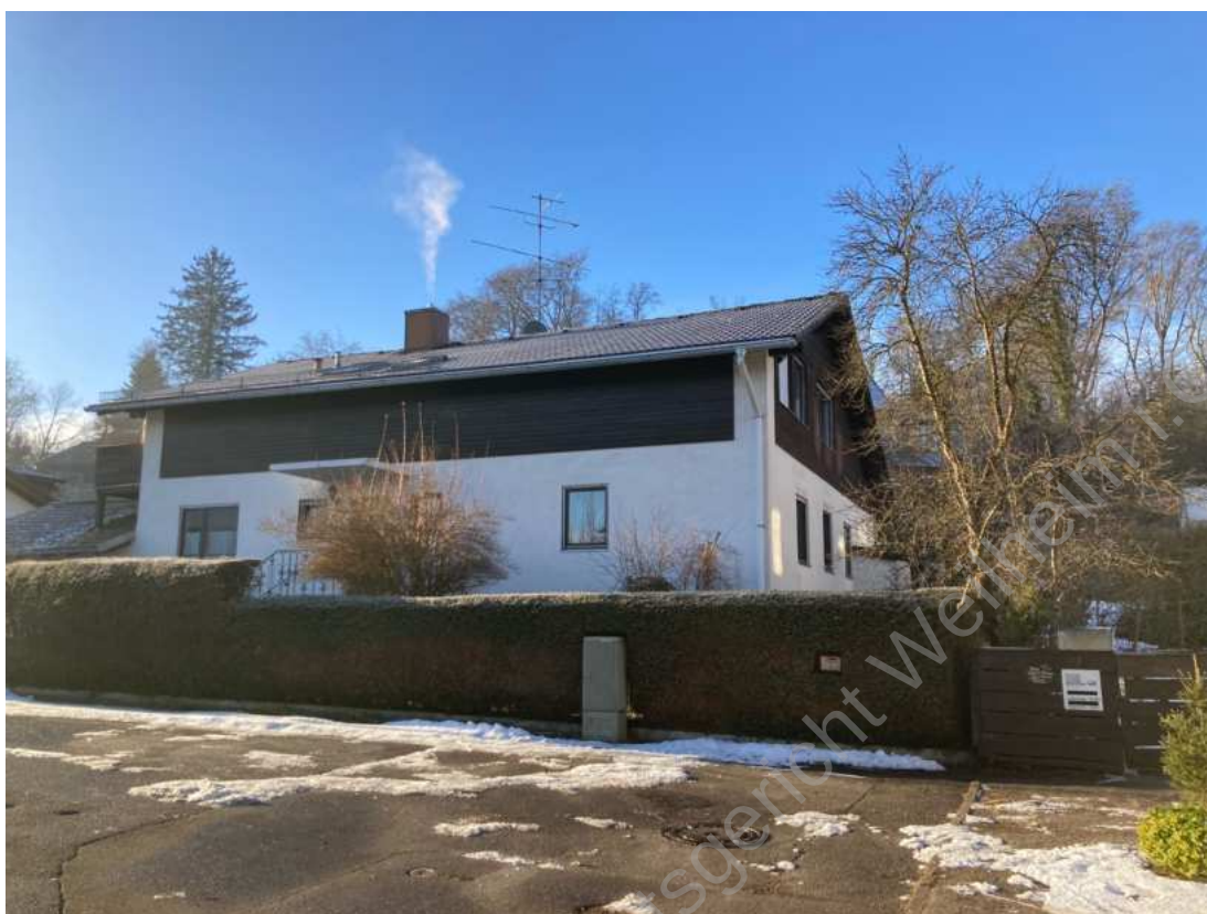
Foto 5: Blick von Norden
