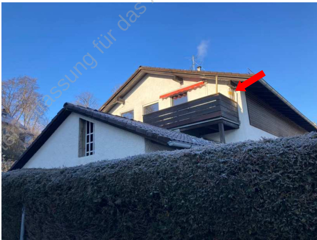
Foto 6: Südostgiebel mit Balkon
