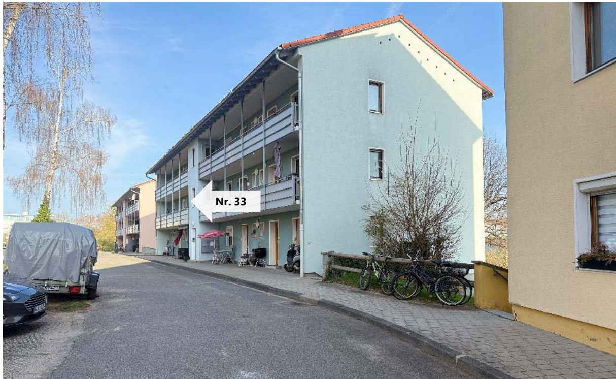
Abbildung 1 Ansicht von Südosten
